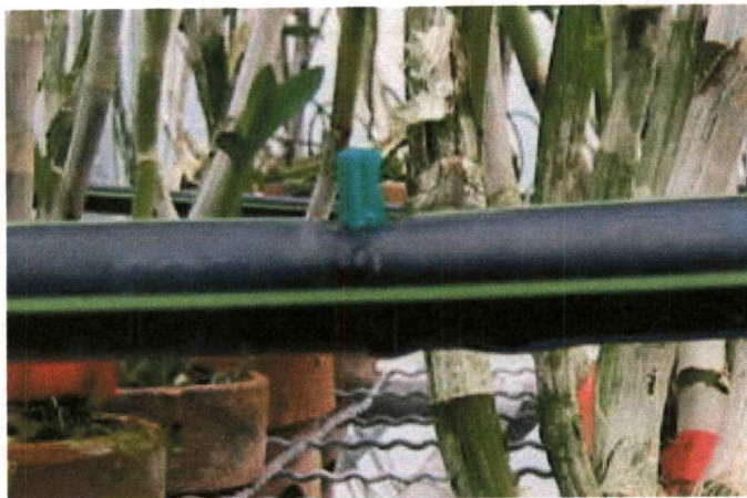
ภาพที่ 3.3 ลักษณะหัวสเปร์ยและท่อที่ให้ปุ๋ยร่วมกับระบบน้ำ
