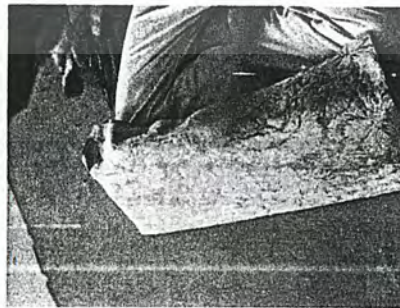
ภาพที่ 2.3-15 ใช้เครื่องยิงตะปูเป็นอุปกรณ์ช่วยในการยึดผ้ากับโครงสร้าง
