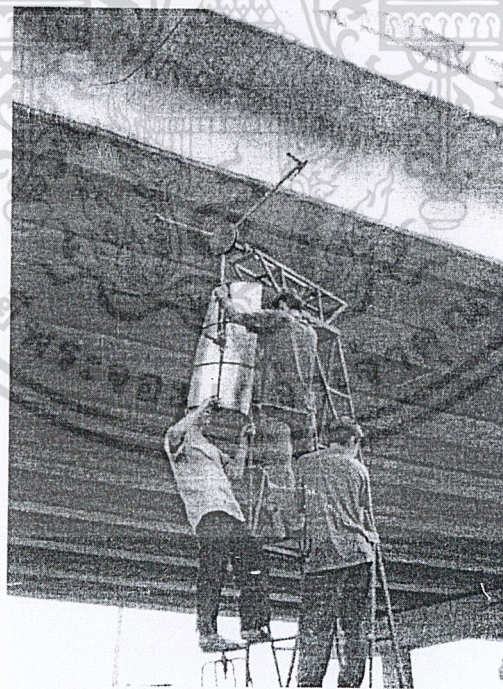
รูปที่ 8-15 แสดงการประกอบชุดใบพัดเข้ากับแกนหมุน
