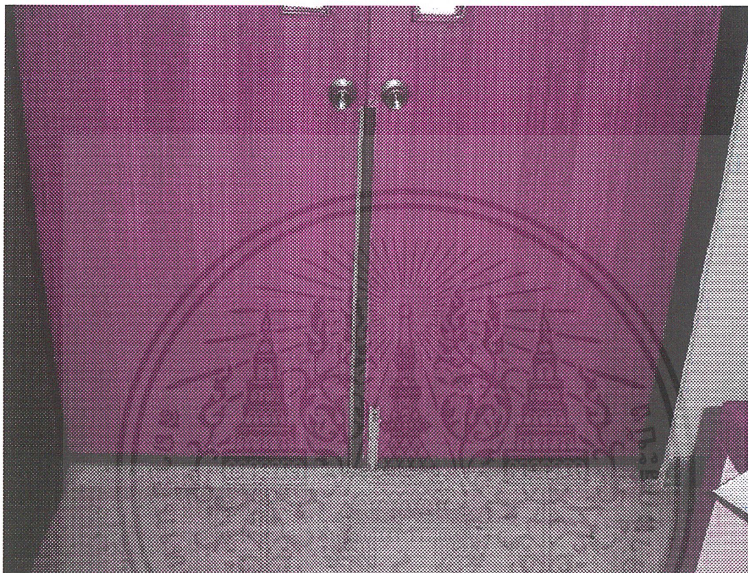
รูปที่ 3.5 แสดงวิธีการนำวัสดุมาติดที่ช่องระหว่างประตู
