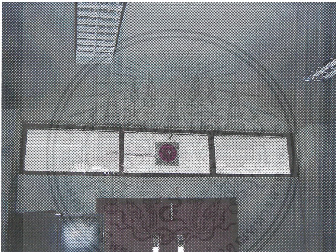
รูปที่ 3.3 แสดงการนำพลาสติกใสมาติดกับช่องแสงที่อยู่เหนือบริเวณประตู
