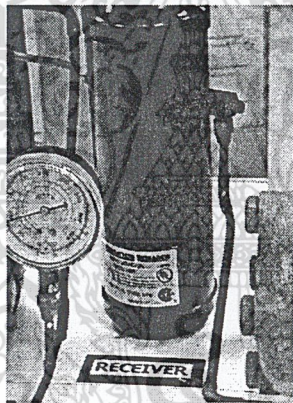
รูปที่ 3-6 แสดงถังพักสารความเย็น (Receiver)
