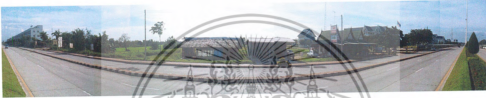
ภาพที่ 4.3.3.1 แสดงที่ตั้งโครงการ A มองจากภายนอกเข้าสู่ด้านหน้าที่ตั้ง
