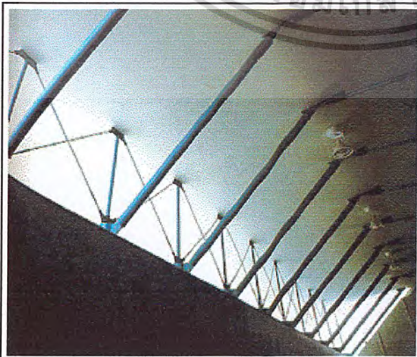
ภาพที่6.2.2.7 Detail of cantilever truss
