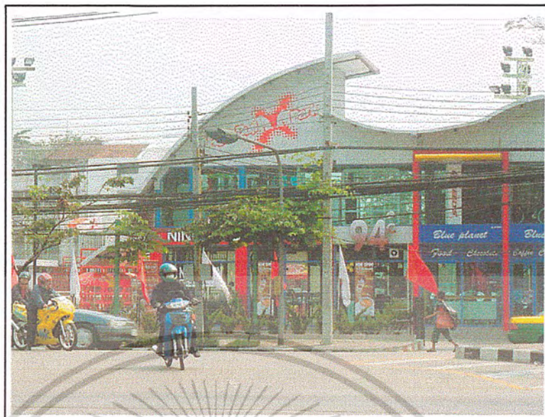
ภาพที่ 6.1.2.8 ลักษณะของอาคาร (สร้างเสร็จแล้ว)
