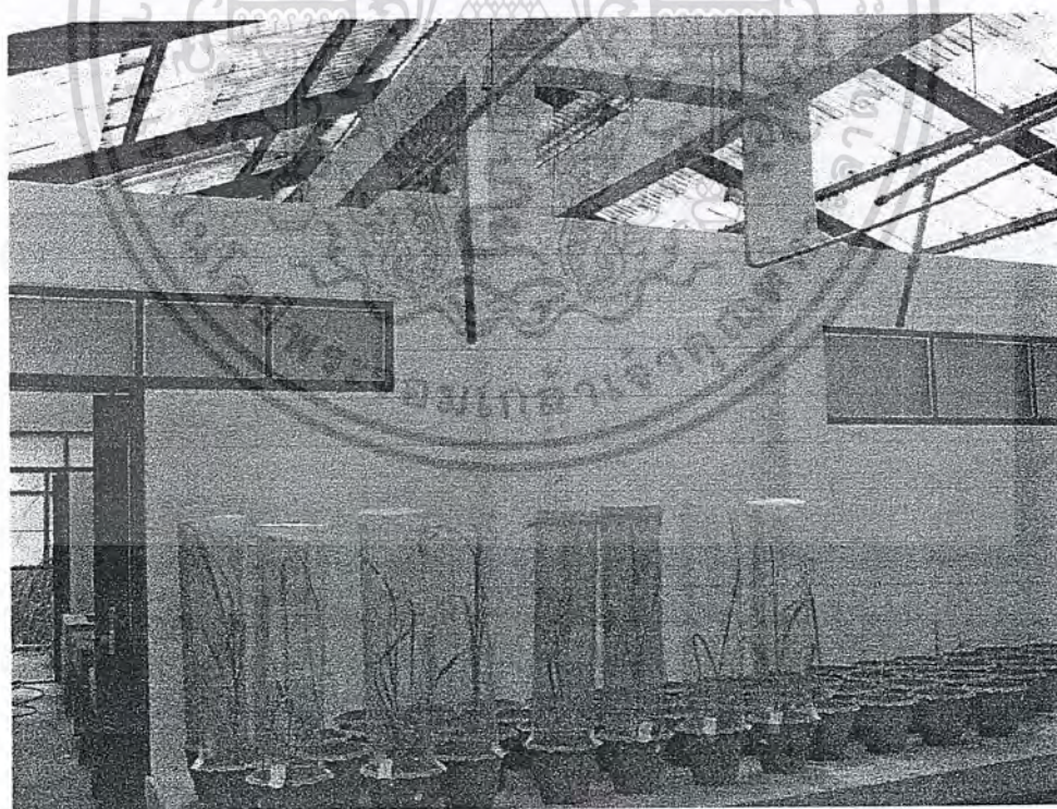
ภาพที่ ๔.๑.๒๐ ภายในเรือนทดลอง (Green House) แสดงให้เห็น หัวจ่ายน้ำอัตโนมัติ ซึ่งต่อพ่วงกับระบบปั้มน้ำและ Timer
