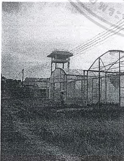
ภาพที่ ๔.๔.๙ แสดงให้เห็นถังเก็บน้ำบริเวณหอคอย เพื่องานในระบบจ่ายน้ำอัตโนมัติของอาคาร
