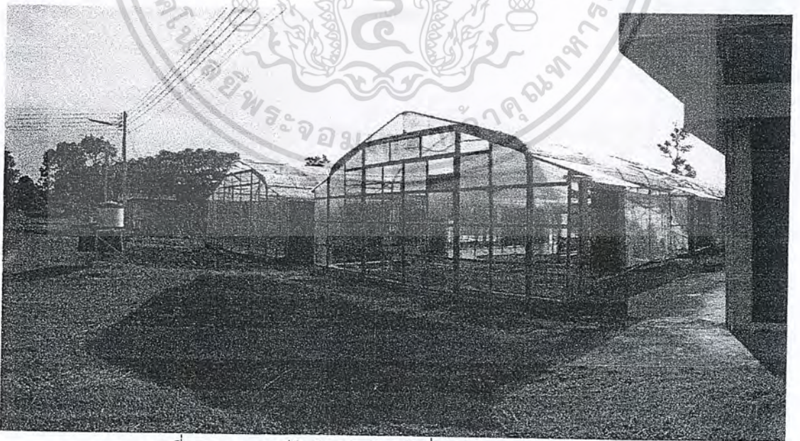
ภาพที่ ๕.๔.๑๑ แผงสีดำด้านข้างทำหน้าที่ระบายอากาศ และความร้อน
