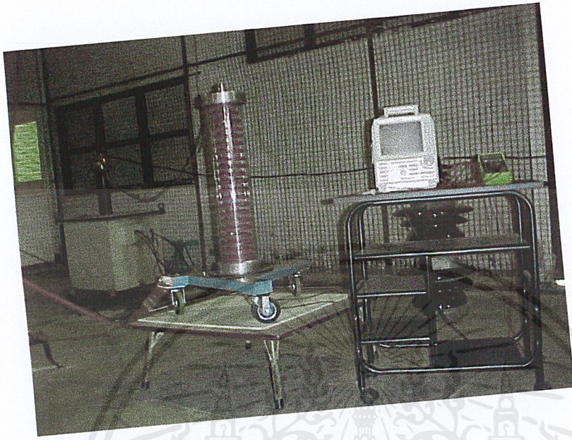
รูปที่ ค.7 การทดสอบดีไวเตอร์ ณ ห้องปฏิบัติการไฟฟ้าแรงสูง ภาควิชาวิศวกรรมไฟฟ้า สถาบันเทคโนโลยีพระจอมเกล้าเจ้าคุณทหารลาดกระบัง
