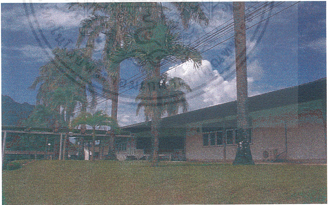
รูปที่ 3.10 อาคารที่ทำการด้านทิศตะวันตก [9]
