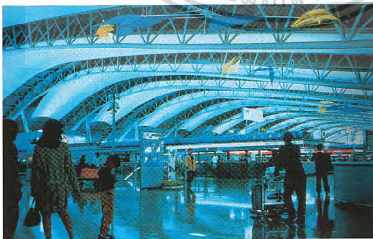
รูปที่ 3.2.3 - 7 ภายในอาคารผู้โดยสาร มองเห็นส่วนโครงสร้างฝ้า เพดานที่ใช้บังระบบปรับ อากาศ Open Air Duct
