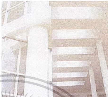
ภาพที่ 1.17 แสดง หลังคาด้านทิศเหนือ ในส่วน ที่วางที่ เชื่อมระหว่าง โถงต้อนรับและโถงตรวจสัตว์
