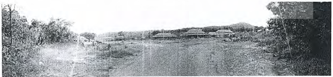
รูปที่ 4-5 แสดงทางเข้าที่ตั้งโครงการจากด้านทิศเหนือ
