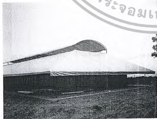
รูปที่ 4-12 แสดงภาพอาคารชั่วคราวที่ใช้ในงานชุมนุมลูกเสือโลก
