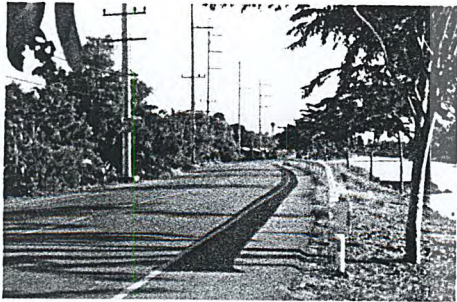
ภาพที่ 7 แสดงถนนตลอดหลวง หน้าโครงการ
