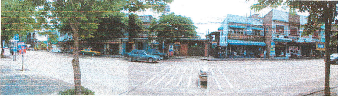
รูปที่ 4.11 อาคารพาณิชย์ด้านตรงข้ามโครงการ เป็นอาคารเก่าสูง 2 ชั้น
