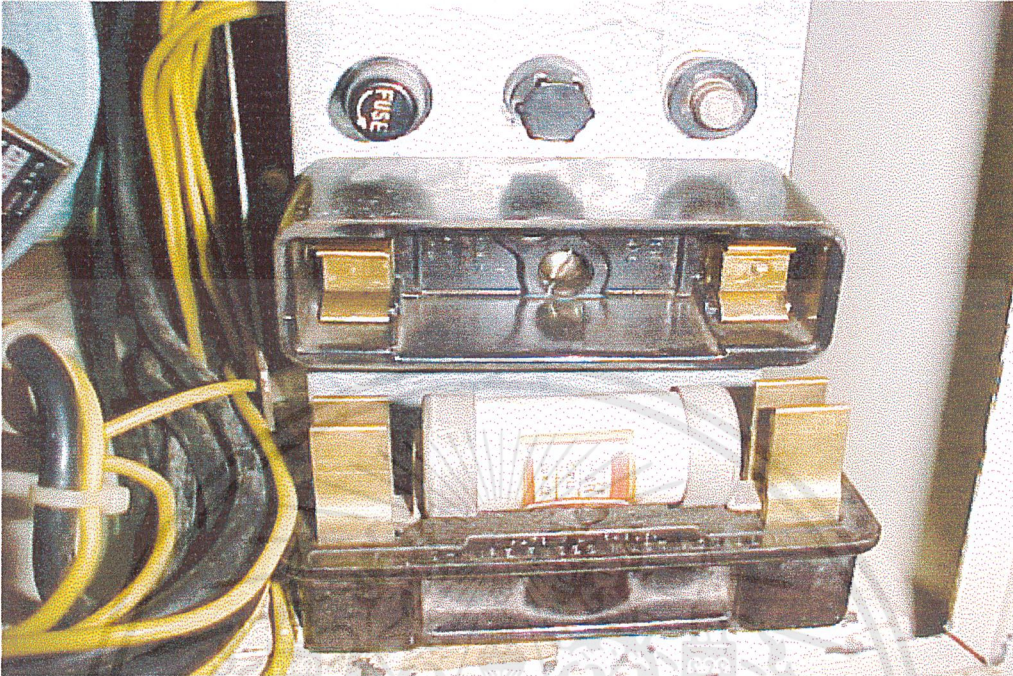
รูปที่ 3.3 ลักษณะของฟิวส์
