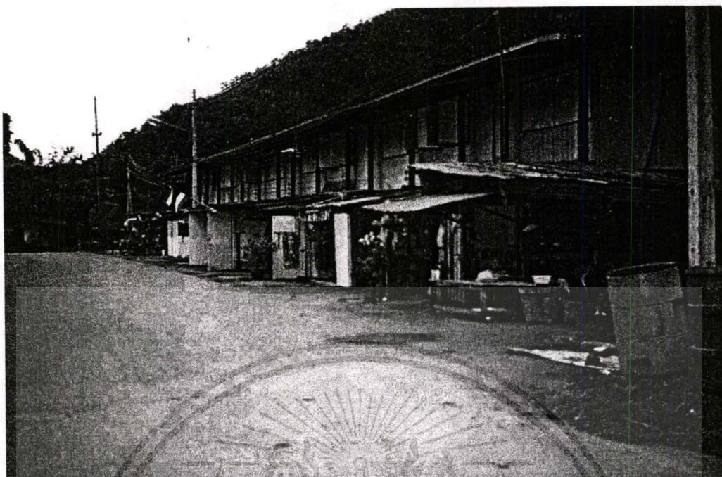
ภาพที่ 2.7 ลักษณะบ้านพักประจำแผนก หมู่ 4 (ด้านหน้าซึ่งมีการต่อเติมเป็นร้านขายของ)
