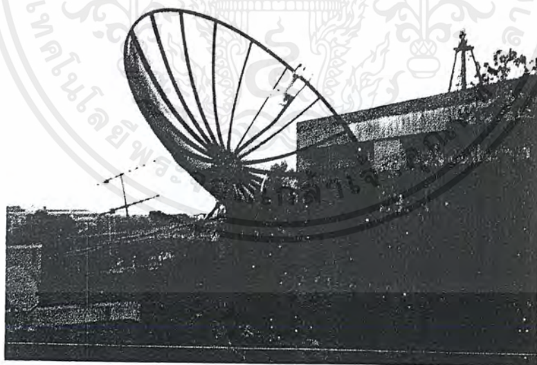
รูปที่ 2.3 โครงสร้างงานพาราโบลาแบบดาข่ายอลูมิเนียมมีคุณสมบัติลดแรงต้านลม
