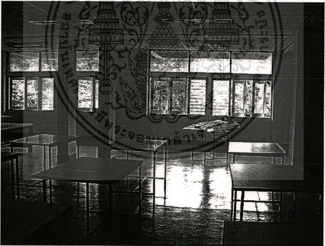
รูปที่ 1.1 แสดงปัญหาแสงสว่างไม่เพียงพอและมีความจ้าของแสงจากการสะท้อนของวัสดุภายในห้องปฏิบัติการเขียนแบบที่จำการศึกษา
