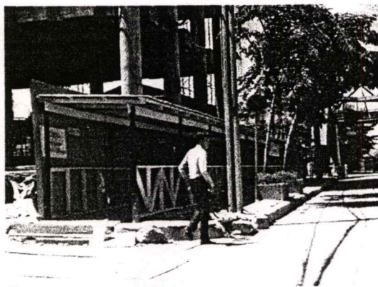
รูปที่ ง.20 แสดงการจัดทำรั้วรอบบริเวณก่อสร้าง
