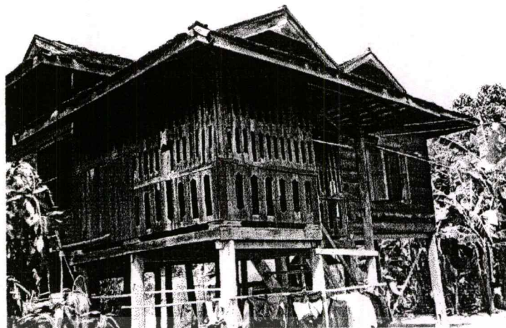
รูปที่ 3.64 แสดงผนังทึบได้ทางด้านหน้าเรือนเป็นผนังโปร่ง และมีช่องเปิดน้อย
