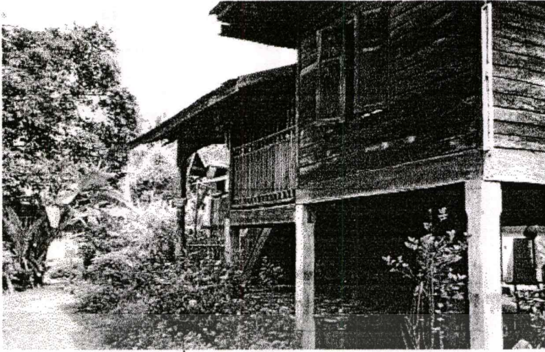
รูปที่ 3.45 แสดงลักษณะช่องเปิดที่เป็นบานไม้ทึบและมีจำนวนน้อย
