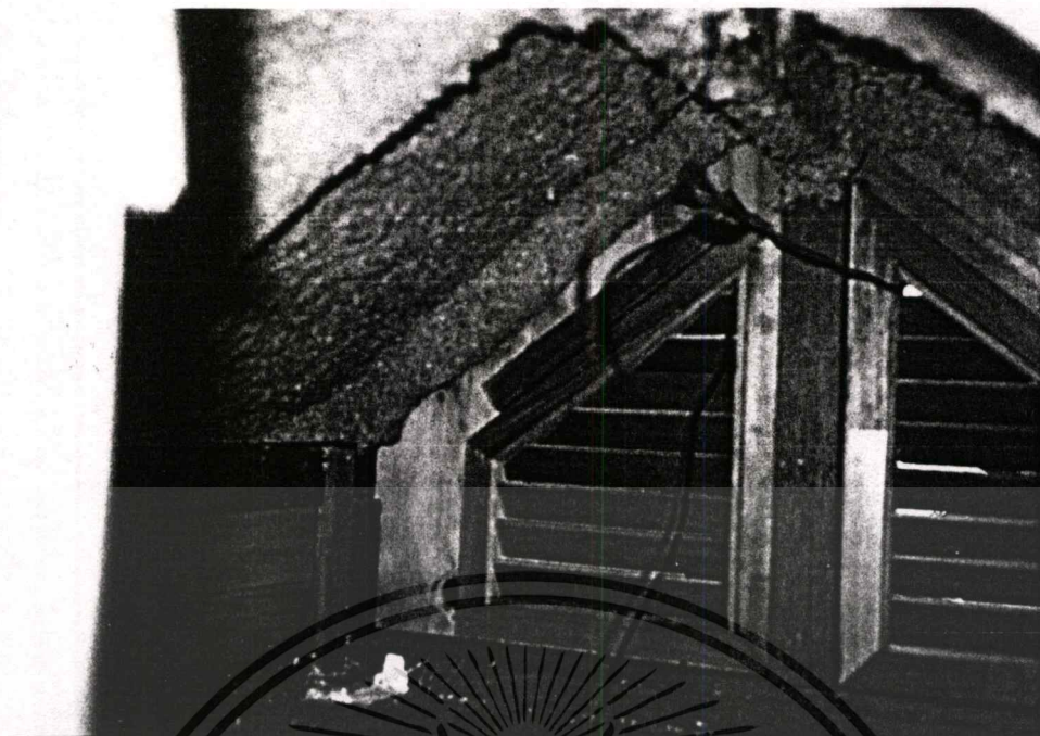
ภาพที่ 4.34 แสดงภาพการวัดอุณหภูมิในช่วงใต้หลังคาของฉนวนเยื่อกระดาษ
