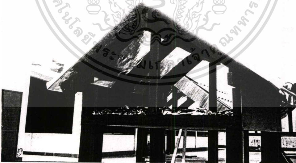
ภาพที่ 4.21 แสดงการติดตั้งอลูมิเนียมพล้อย และวางฉนวนใยแก้วบนผ้า
