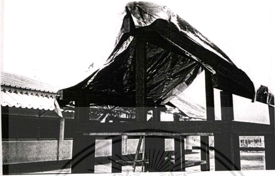
ภาพที่ 4.20 แสดงการติดตั้งอลูมิเนียมพล้อย กับทุกหลังที่ใช้ฉนวนใยแก้ว
