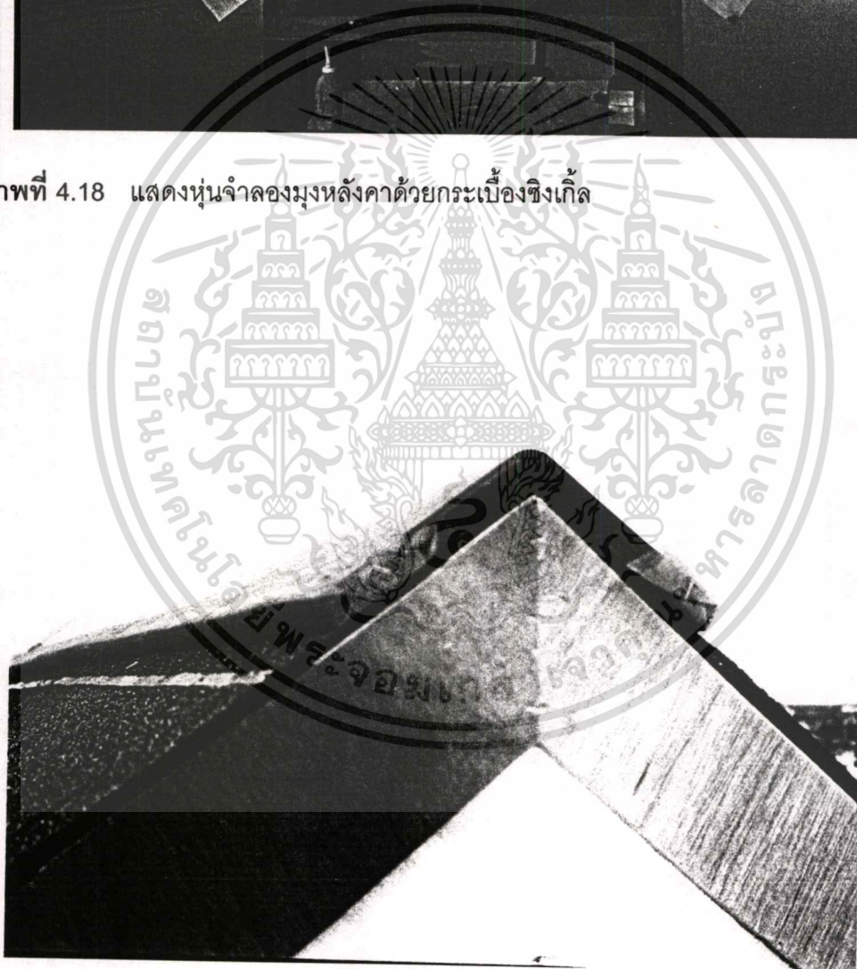
ภาพที่ 4.19 แสดงช่องระบายอากาศบนสันหลังคาของกระเบื้องชิงเกิ้ล
