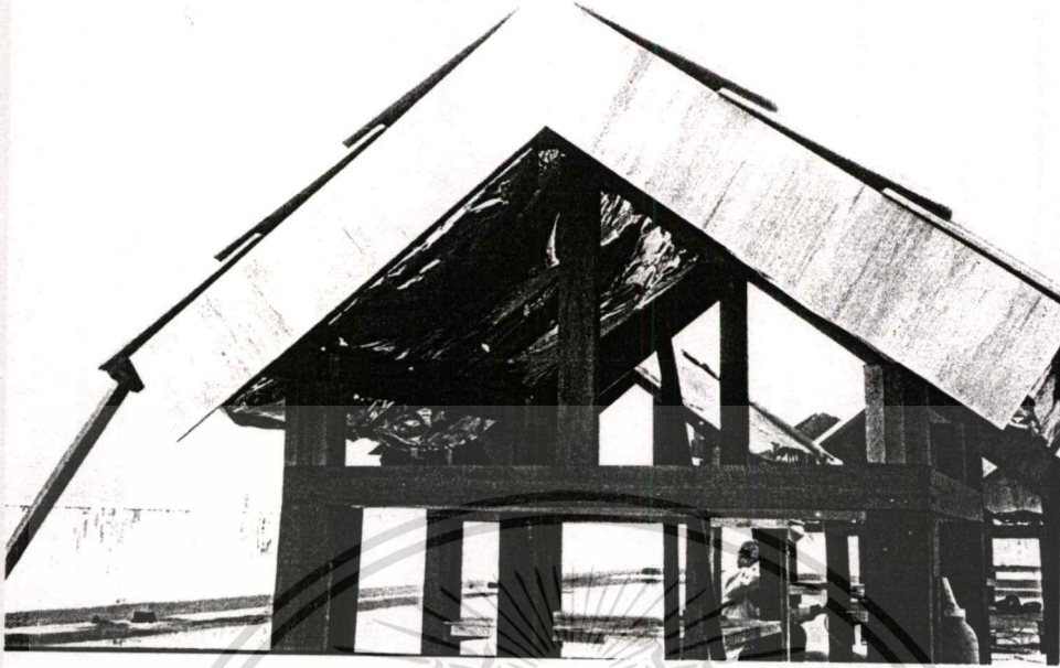
ภาพที่ 4.14 แสดงการติดตั้งกระเบื้องคอนกรีต (CPAC) กับฉนวนใยแก้ว (Roof batt) ระหว่างจันทัน
