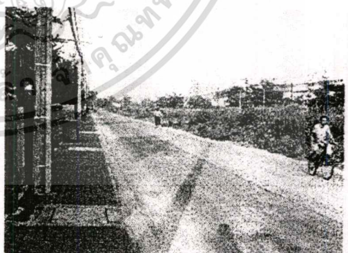
ถนนหลวงพรค เป็นถนนขนาด 2 ช่องจราจร มีความกว้าง 6.0 ม. พื้นที่ว่างด้านข้างด้านข้างทางรถไฟมีความเป็นไปได้ที่จะขยายพื้นผิวถนนออกไปได้อีก และสามารถปรับปรุงให้เป็นทางเฉพาะสำหรับจักรยานขึ้นมาได้ (ทางเข้าโรงเรียนพรตพิทยพยัต)
