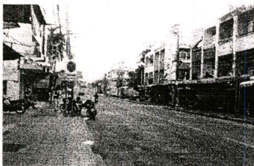
ถนนฉลองกรุง เป็นถนนขนาด 2 ช่องจราจร มีความกว้าง 10.0 ม. เส้นทางนี้มีความเป็นไปได้ที่จะเพิ่มเติมช่องทางจักรยานขึ้นมาบริเวณริมถนนทั้งสองด้านเพื่อรองรับการใช้จักรยานเดินทาง (หน้าโรงงาน FBT)
