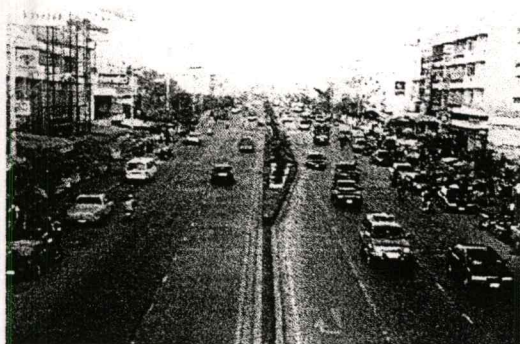
ถนนอ่อนนุช - ลาดกระบัง ซึ่งเป็นถนนขนาด 6 ช่องจราจร มีความกว้างทิศทางละ 9.5 ม. เส้นทางนี้มีความเป็นไปได้ที่จะสามารถปรับลดความกว้างของเกาะกลางถนนลงได้อีก เพื่อขยายผิวจราจรรองรับการเดินทางด้วยจักรยาน (หน้าโรงพยาบาลลาดกระบัง)
