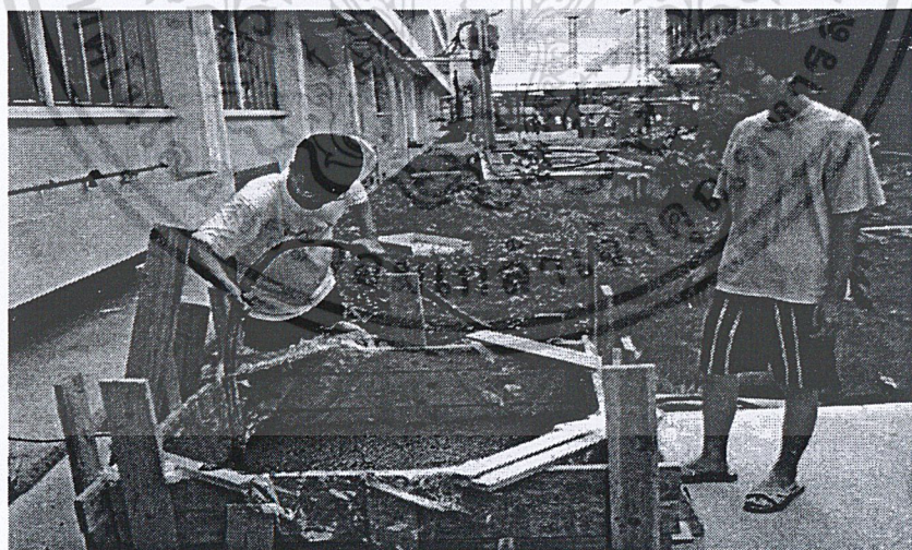
รูปที่ ผ.ค.4. แสดงการจี้คอนกรีตเป็นชั้นๆ
