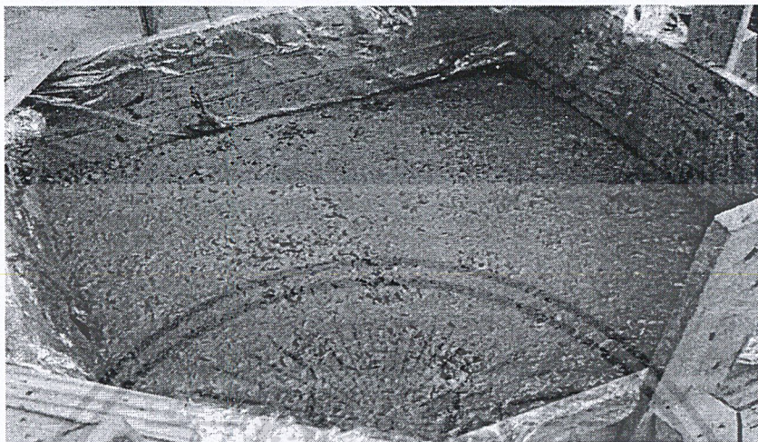
รูปที่ ผ.ค.3. แสดงการเทคอนกรีต โดยแบ่งเทเป็น 3 ชั้น ชั้นละ 10 เซนติเมตร
