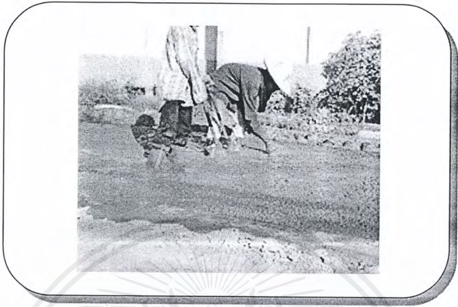
รูปที่ 7. การใส่เหล็กยึดตามขวาง
