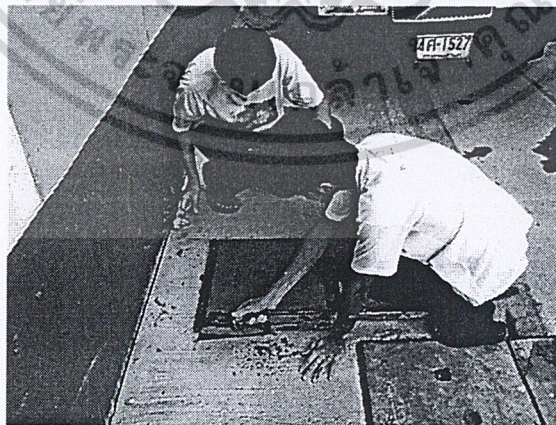
รูปที่ ผ.จ.17. แสดงการหล่อชิ้นงานช่องระบายอากาศ
