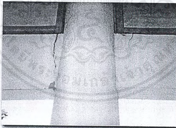
รูปที่ 3.3 ลักษณะแตกจากด้านบนของคานและไล่ลงมา
