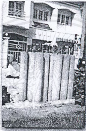
รูปที่ 4.6 เสาเข็ม FN- Pile
