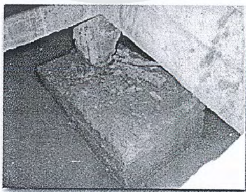
รูปที่ 2.10 (ข) ลักษณะเสาเยื้องศูนย์กลาง
