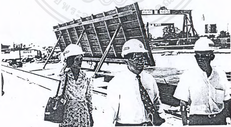
รูปที่ 4.11 การผลิต PC. Panels ด้วย Tilt up Table
