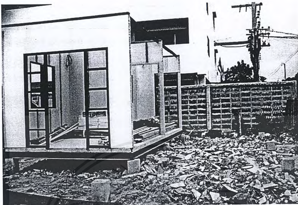
รูปที่ 5.9 แสดงชิ้นส่วน โมดูลาร์หลังติดตั้งกับคานเหล็กแล้ว
