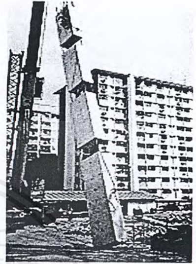
รูปที่ 3.13 การยกเสาสำเร็จรูป ด้วยโมบายเครน
