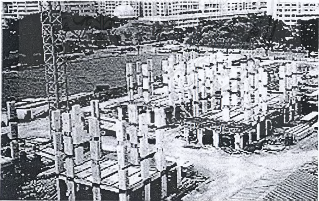
รูปที่ 3.14 แสดงบริเวณ โครงการที่ก่อสร้างด้วยระบบ โครงเฟรม
