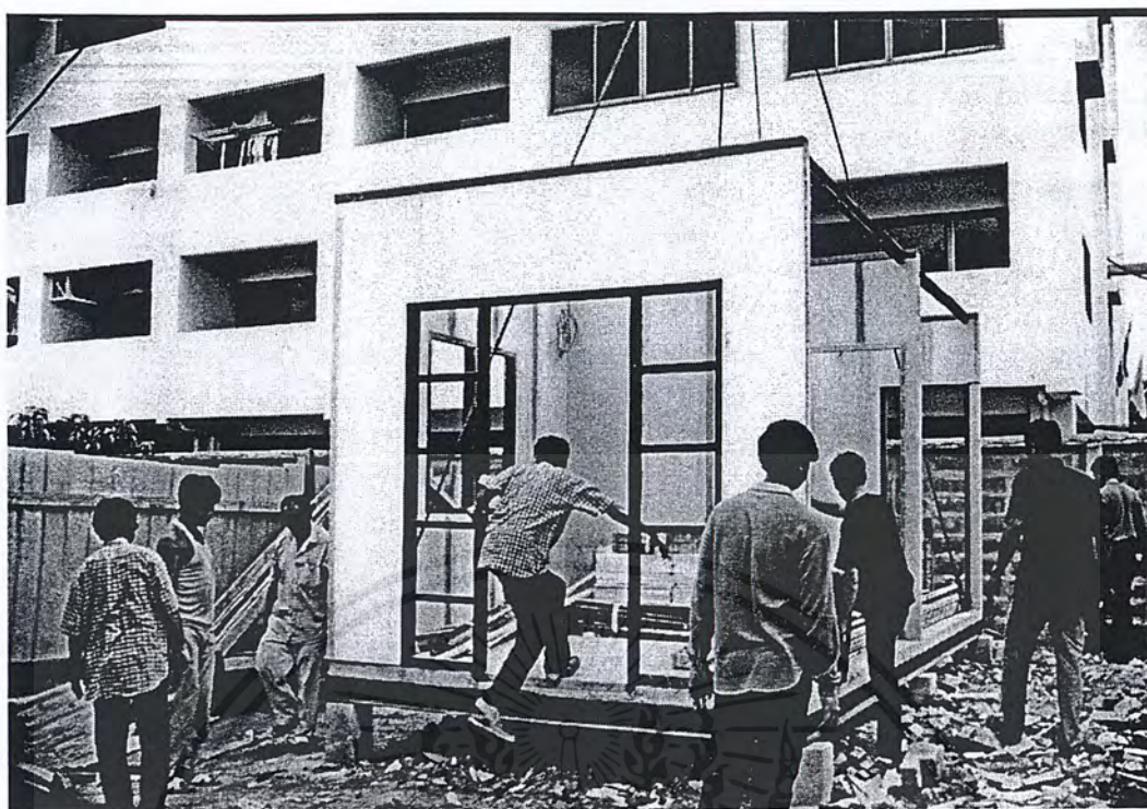
รูปที่ 5.8 (ก) แสดงการวางชิ้นส่วน โมดูลาร์บนคานเหล็กและทำการเชื่อมยึดกับคานเหล็ก
