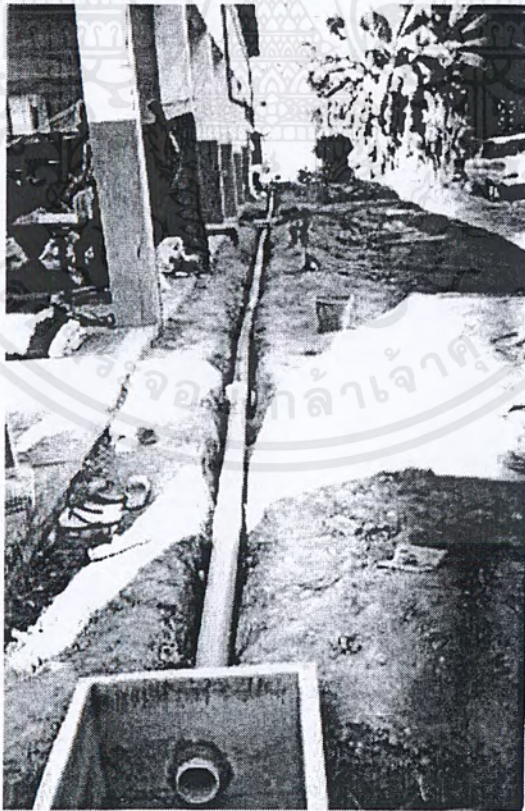
รูปที่ 6.8 ทำการวางแนวท่อ โดยความลาดชันประมาณ 1:200
