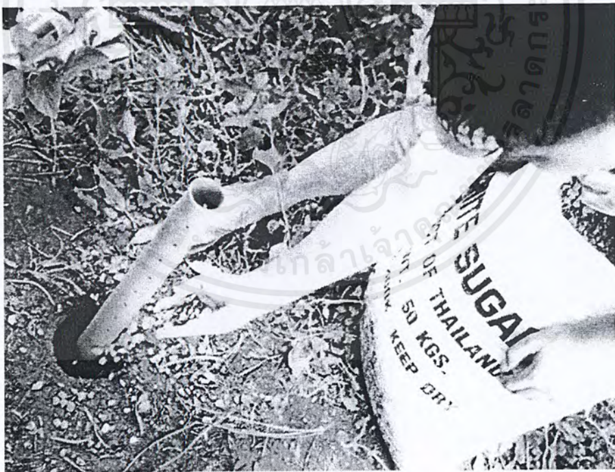
รูปที่ 4.11 การนำท่อลงในหลุมและการเติมหินลงในหลุม
