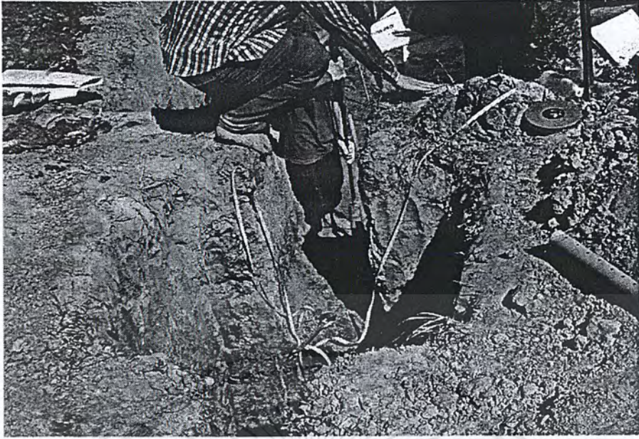
รูปที่ 6.16 การวัดความกว้าง ความยาว และความลึกของบ่อพักน้ำและบ่อดักตะกอน
