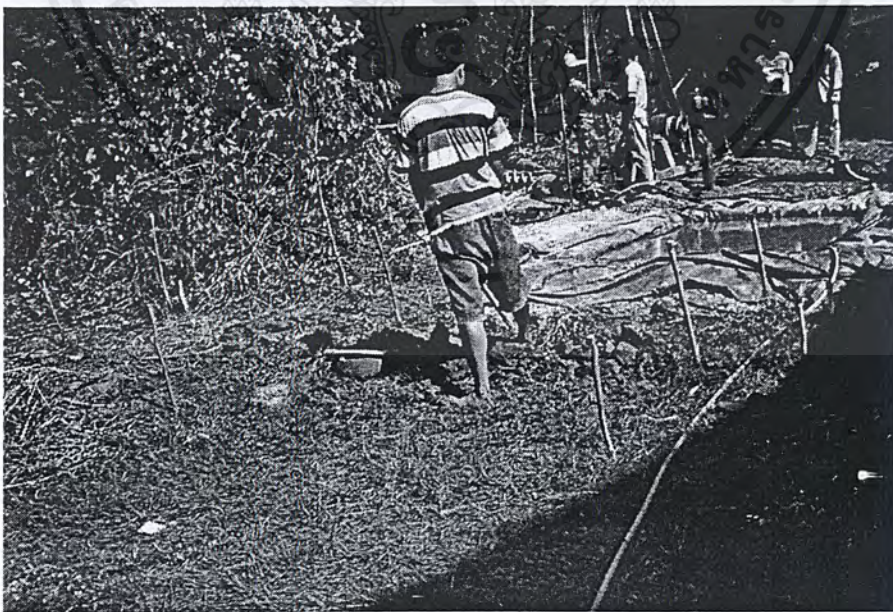
รูปที่ 6.13 การวางตำแหน่งและปักหลักเพื่อทำการขุดบ่อพักน้ำ,บ่อดักตะกอน
