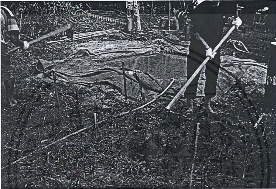
รูปที่ 6.12 การวางตำแหน่งและปักหลักเพื่อทำการขุดบ่อพักน้ำ,บ่อดักตะกอน
