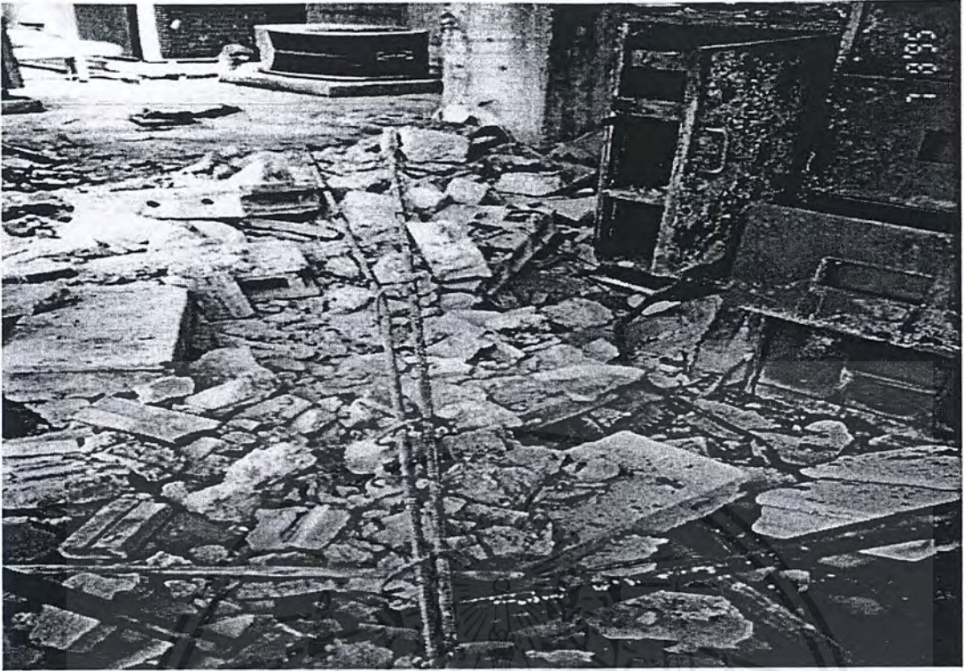
รูปที่ ผ.ก.24. แสดงการเก็บตัวอย่างเหล็กเสริมคานคอนกรีตที่ถูกเพลิงไหม้ไปทดสอบหาแรงดึง
