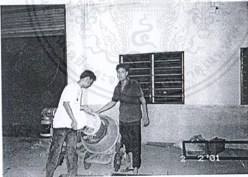
รูปที่ ผ.จ.6. แสดงการผสมคอนกรีตโดยใช้ไม้ผสมขนาดเล็ก ผสมได้ครั้งละประมาณ 0.02 ลบ.เมตร
