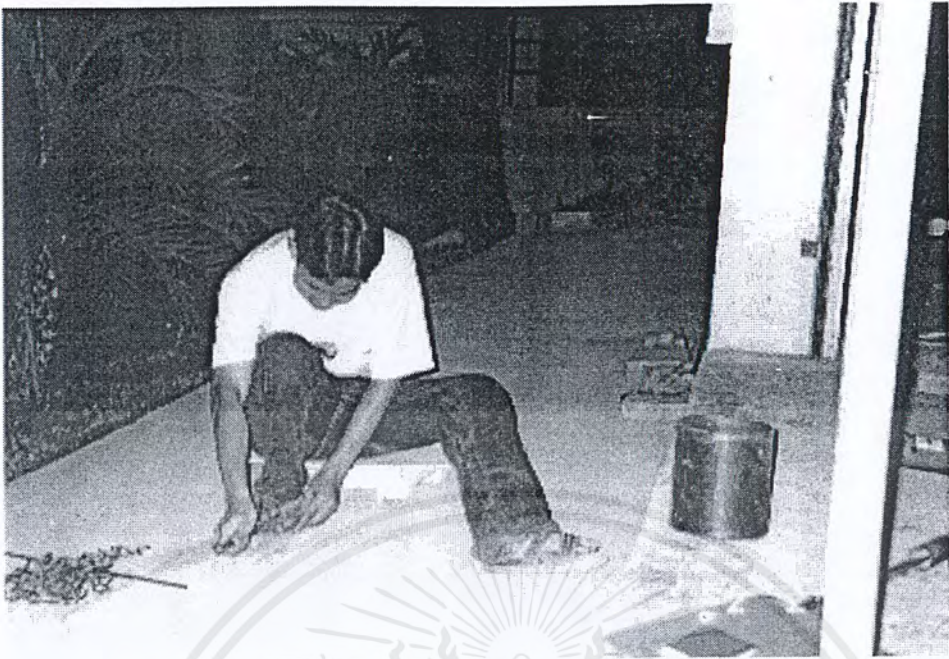
รูปที่ ผ.จ.1. แสดงการงอเหล็กปลอก เพื่อใช้สำหรับทำเป็นเหล็กรับแรงเฉือนในตัวคาน
