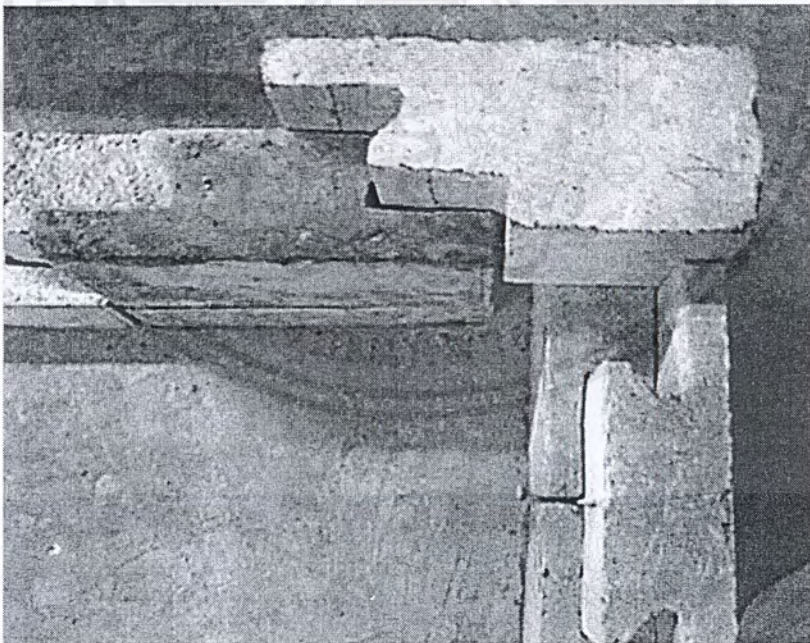
รูปที่ 5.9 การวางอิฐมุมในชั้นที่ 3
