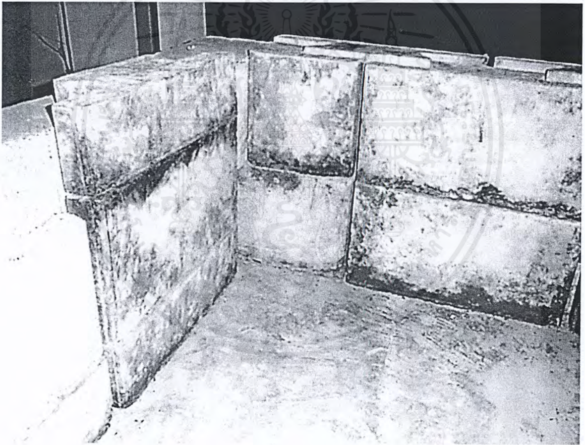
รูปที่ 5.13 กำแพงที่ก่อด้วยอิฐบล็อกแบบล็อกในตัว
