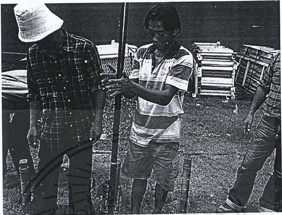
รูปที่ 3.1.11. แสดงการต่อท่อเหล็ก
