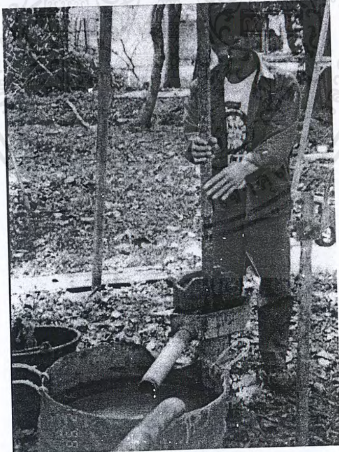
รูปที่ 2.1.7. แสดงวิธีการต่อก้านเจาะ
