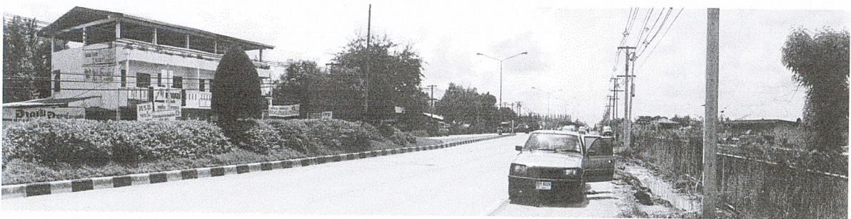
แสดงถนนด้านหน้าที่ตั้ง ถนนสายเชียงใหม่ – หางดง กว้าง 4 เลน
