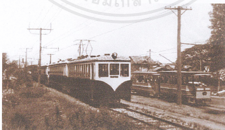
โครงข่ายสายบางกระบือ – สาร ( ต่อขยายจากหัวลำโพงเมื่อราวๆ ปี พ.ศ. 2455 - 2460 )
