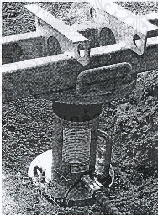
รูปที่ ผ.จ.22. แสดงการติดตั้ง Hydraulic Jack กับคานที่ใช้สมอยึดไว้
