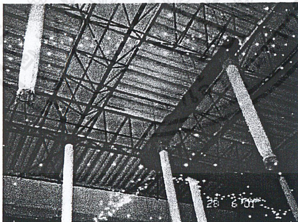
แสดงโครงสร้างหลังคาของอาคารซึ่งเป็นโครง truss
