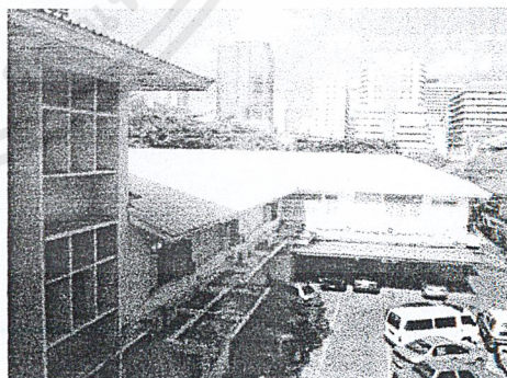
ภาพที่ ๖.๑๙ : แสดงอาคารพิสูจน์หลักฐาน มุมมองจากชั้นที่ ๓ อาคารเก่ามองมายัง อาคารเก่า ๒ ชั้น(อาคารทางเข้าหลัก)
