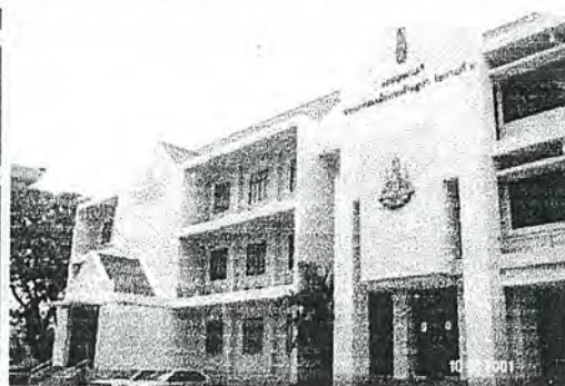
สภาพแวดล้อมภายในด้านอาคารหอสมุดนครี
