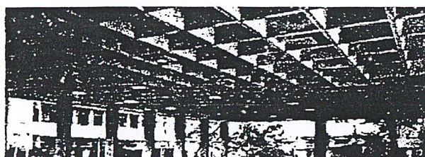
แผ่นพื้นกระทง (WAFFLE SLAB)
