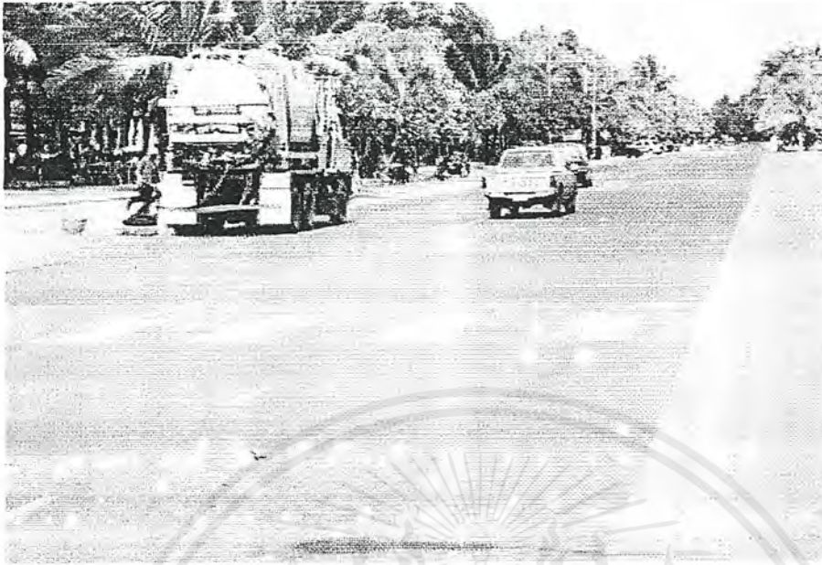
ภาพประกอบที่ 2.3.1.13 เส้นทางถนนสายหลักขนานชายหาดที่เป็นถนนคอนกรีต 2 เลน
