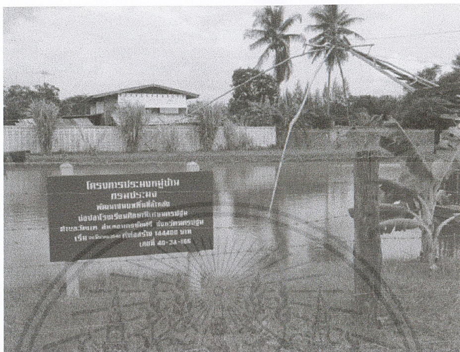
รูปที่ 5 โครงการประมงหมู่บ้านซึ่งอยู่ในโครงการฝึกอาชีพในโรงเรียน เนื่องจากตั้งอยู่บนพื้นที่ลุ่มริมแม่น้ำนครชัยศรี บ่อเลี้ยงปลาทำหน้าที่เก็บกักน้ำชะลอการท่วมได้เมื่อฝนตกหนัก
