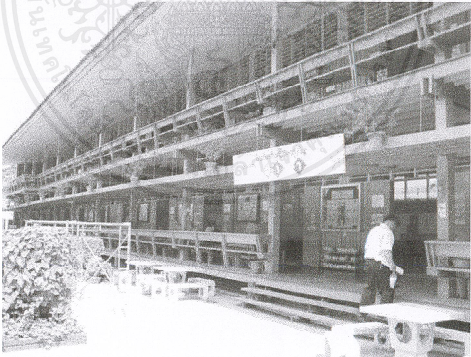
รูปที่ 4 อาคารเรียน 2 ชั้นเป็นอาคารที่ก่อสร้างมานานแล้วมีระเบียงกว้างมีที่นั่งพักผ่อนริมนะเบีย
