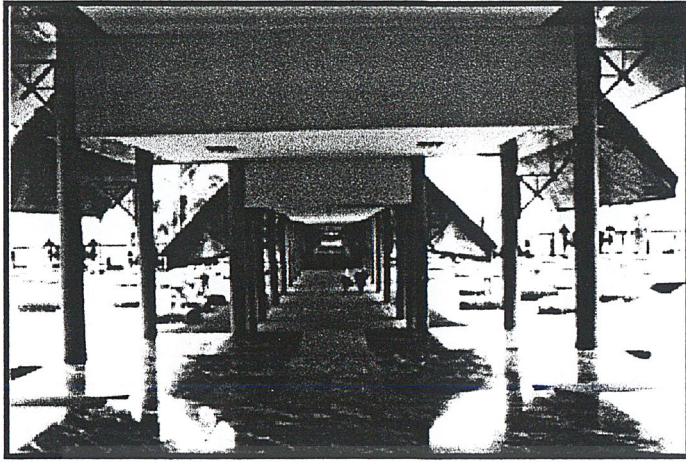
ภาพแสดงมุมมองจากอาคาร หลักย้อนไปยังอาคารอำนวยการ
