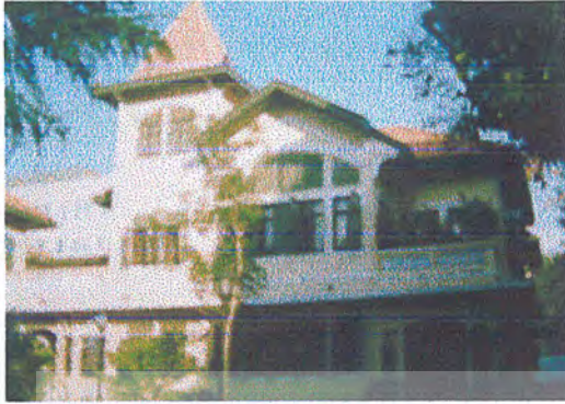
ด้านหน้าอาคารที่กระทบแดด โดยส่วนที่โดนแดดมากจะเป็น ชั้นที่สูงของอาคารบริเวณหอคอย และอาคารด้านหน้า
