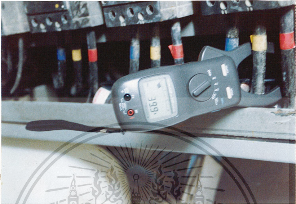
รูปที่ 4.6 การคล้องวัดค่ากระแสของดิจิตอลแคลมป์มิเตอร์ที่ชั้น 3 เฟส S
