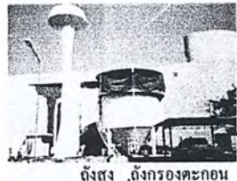
ถังสูง ,ถังกรองตะกอน
