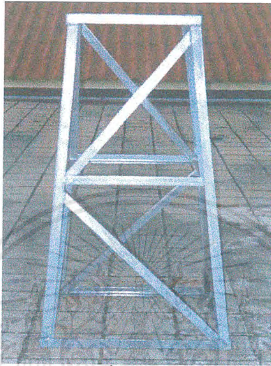
รูปที่ 6.11 โครงเหล็กส่วนบน
