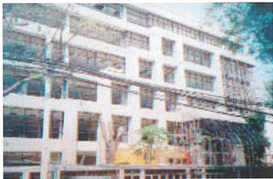
รูปด้านทิศใต้ บริเวณด้านหน้าอาคารทางเข้าสู่โครงการ
