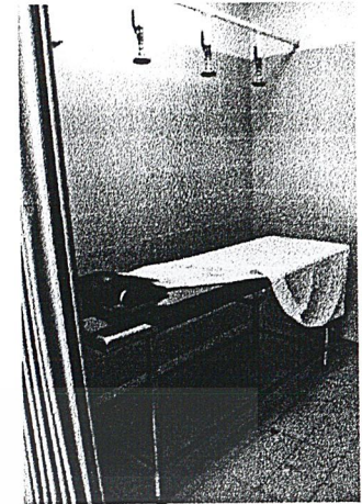
ภาพที่ 2.30 แสดงส่วนห้องบำบัดด้วยการฉีดและอบไอน้ำ
