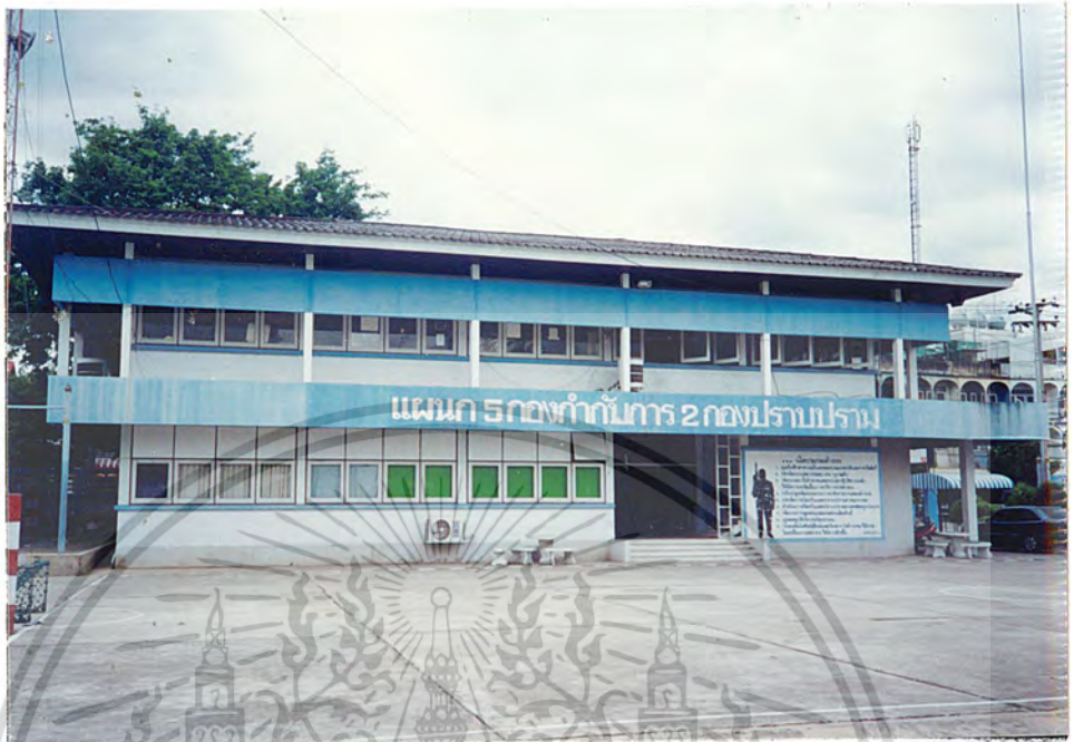
ภาพที่ 5.1.7. อาคารสำนักงาน
